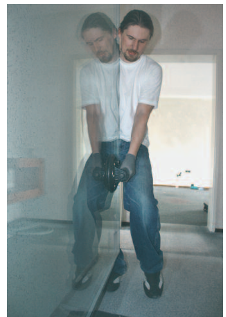
GFF -Redakteur Matthias Heiler musste auf der Baustelle anpacken.
