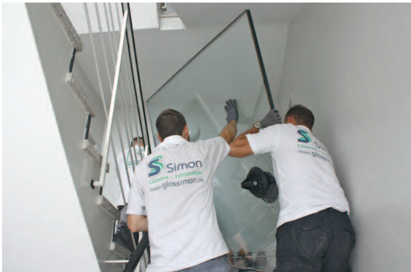
Mit vereinten Kräften hieven Glasermeister Jürgen Simon (re.) und seine Mitarbeiter das Zweifachisolierglas durchs Treppenhaus.
