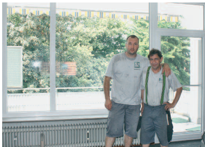
Erfolgreiches Tagwerk: Goran Koncarevic (li.) und Andreas Ludwig freuen sich über das montierte PVC-Fenster samt Balkontür.
