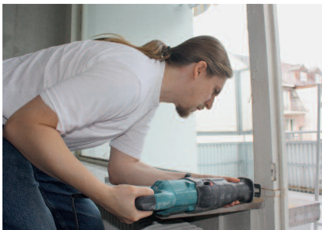
Beim Ausbau des alten Holzrahmens forderte Glasermeister Jürgen Simon chirurgische Präzision von GFF-Redakteur Matthias Heiler.
